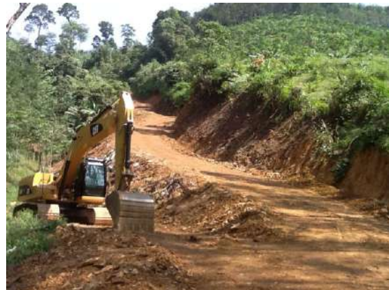
งานก่อสร้างผิวทางแบบลูกรัง
