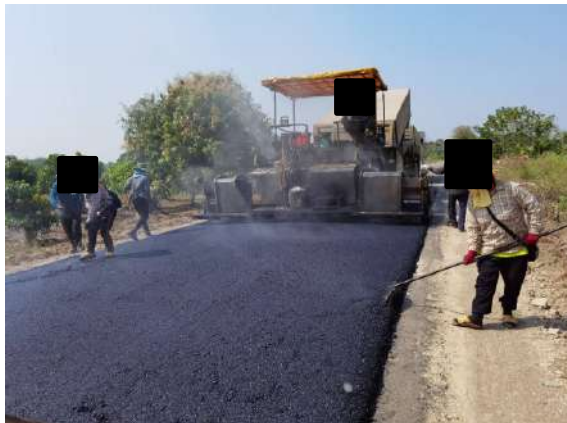
งานก่อสร้างผิวทางแบบ Asphaltic Concrete
