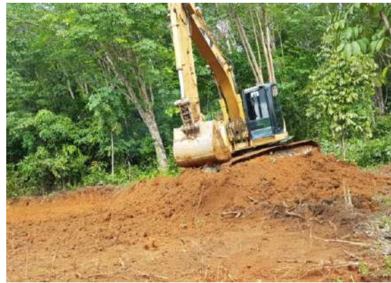
งานแผ้วถางเตรียมพื้นที่ ขุดเปิดหน้าดิน
